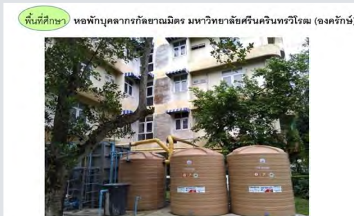
ถังสำหรับน้ำรีไซเคิล
