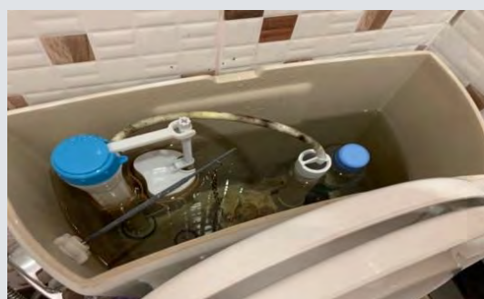
การติดตั้งขวดน้ำเพื่อลดการใช้น้ำลง 25%
